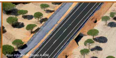
Paso inferior de fauna A-494.
